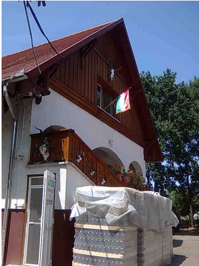
A bejárattal szembeni üzemi épület
