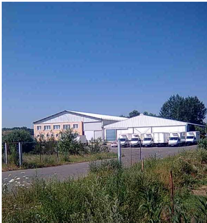
A 0461/35. hrsz-ú ingatlanon található ipari épületek.
